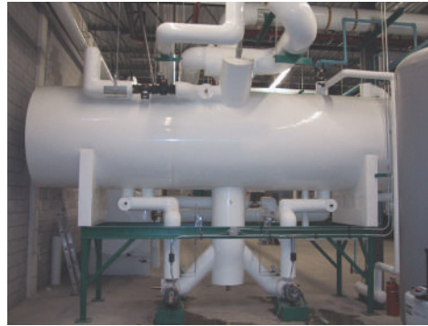
Isolant en mousse Styrofoam® utilisé pour l'isolation de réservoir.
