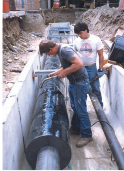
Installation d'une gaine Pittwrap® sur de l'isolant Foamglas® posé sur une conduite de vapeur enterrée.
