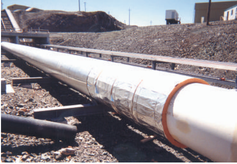
Système d'isolation par enveloppe avec chanfrein, fabriqué par Polybrand inc. avec de la mousse Trymer®, installé sur une canalisation de grand diamètre transportant des produits pétroliers.
