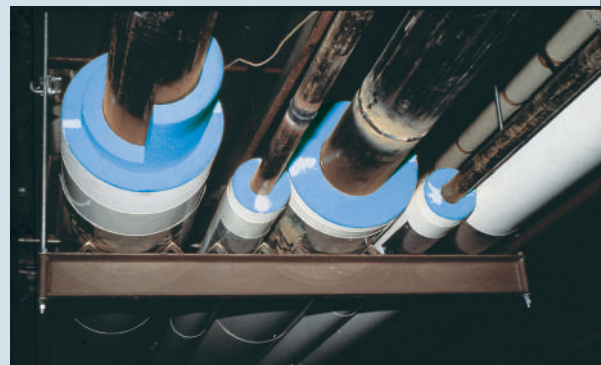
Revêtement d'isolant Trymer® sur un réseau de tuyaux.
