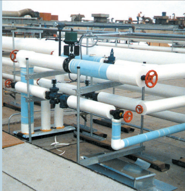
Installation de revêtement de demi-coquilles de Styrofoam®
